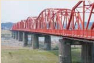
1926年に中村地区と具同地区を結ぶ交通手段として架けられた鉄橋です。構造は下路単純ワーレントラスと鉄骨コンクリート単純桁から成り立っています。
