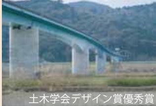
四万十川に架かる橋長697mの箱桁ラーメン橋です。「四万十川の自然風景を生かすシンプルな橋」をコンセプトに、道路線形、橋脚柱の形状などがデザインされています。
